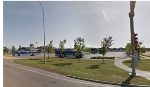
1 Eaux Claires Transit Centre
