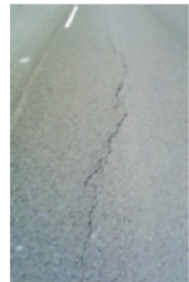
Longitudinal crack
